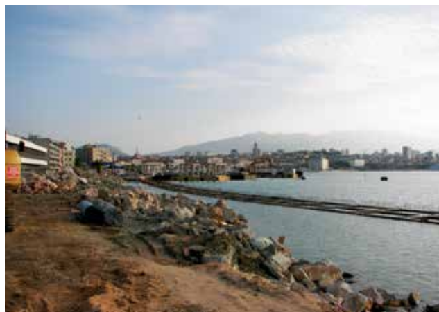
Gradnja nove obalne linije
