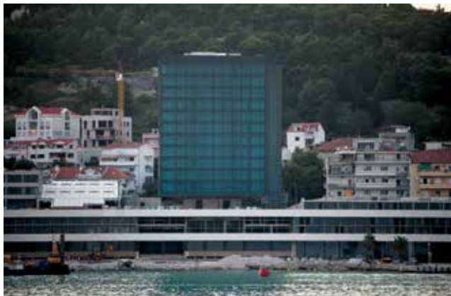
Pogled s mora na radove na Zapadnoj obali
