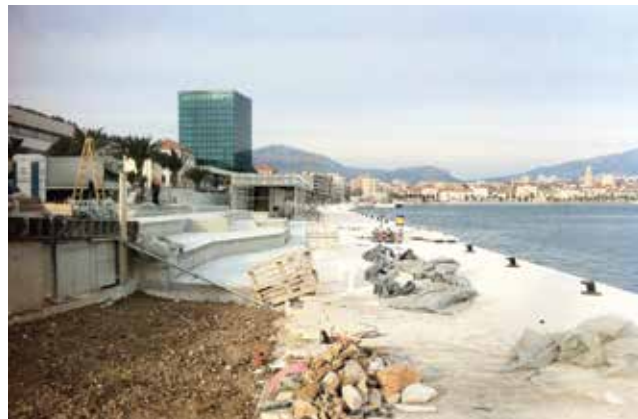
Završni radovi na Zapadnoj obali
