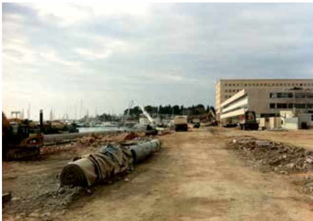
Radovi na novom nasutom dijelu Zapadne obale
